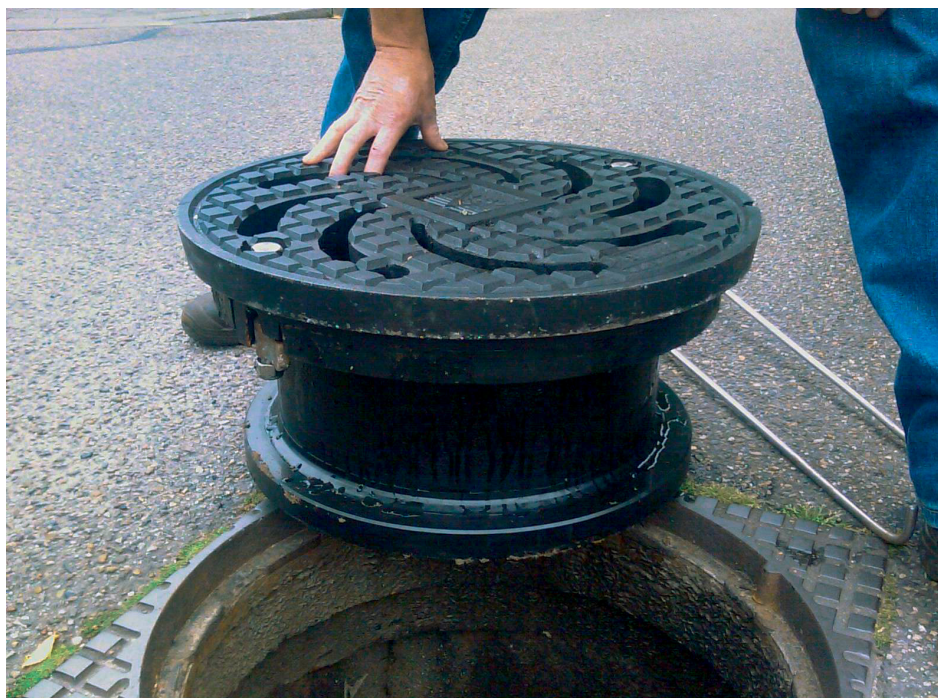
Figuur 17.20 Plaatsing van een ontluuchtingsputdeksel (Bron: TBS)
